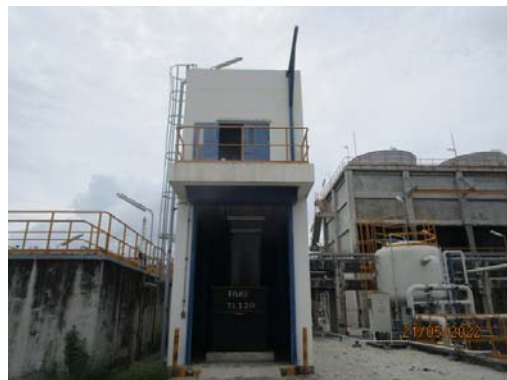
รูปที่ 3.2-37 ภาชนะรวบรวมกากตะกอน จากระบบบำบัดน้ำเสีย
