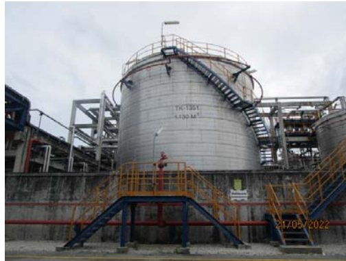
รูปที่ 3.2-57 ถังคอนกรีตล้อมรอบถังเก็บกัก
