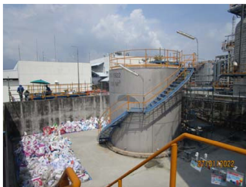
รูปที่ 3.1-9 Bund รอบเขตพื้นที่ก่อสร้าง
