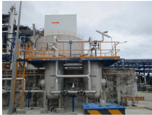
รูปที่ 3.2-6 ปล่องระบบดูดซับไอระเหยสารอินทรีย์ด้วยถ่านกัมมันต์ จากถัง TK-1922 TK-1923 (D-1906)
